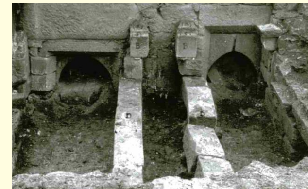
Vue de l'hypocauste lors du démontage de l'étuve photo, collection Y. de Brunhoff©
