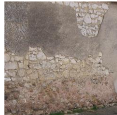
Le moellon enduit
