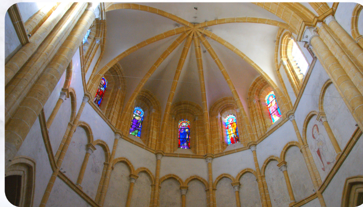
Voûtes du chœur
