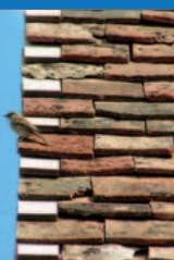
Rive avec demi-tuile en bardeau de bois.
