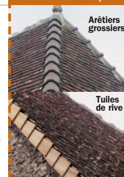
Solin pour arêtiers, rive haute contre un mur et rive latérale en pénétration. Solin : étanchéité, mortier de chaux naturelle et sable dans la couleur des enduits de maçonnerie (Poncé-s-le-Loir).
